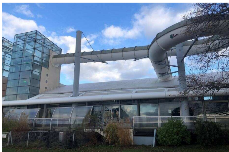
La piscine Aquarive à Quimper (Finistère). (Photo d'illustration) | ARCHIVES OUEST-FRANCE
